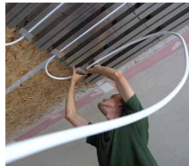
Do lamel se poté navakne trubičkový systém a celý systém se zaklopí sádkartonovými deskami
