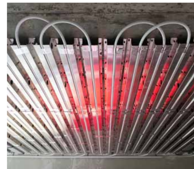
Díky našemu systému stropního nebo stěnového vytápění a chlazení dosáhnete energeticky významných úspor
