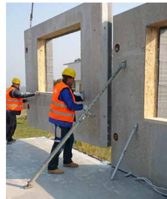
Jedno patro rodinného domu postavíme během 8 hodin
